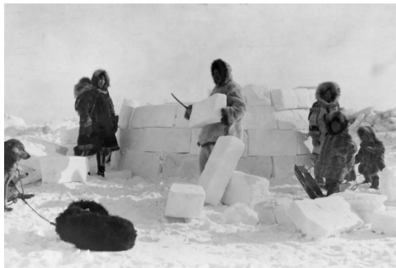
Construction d'un igloo
