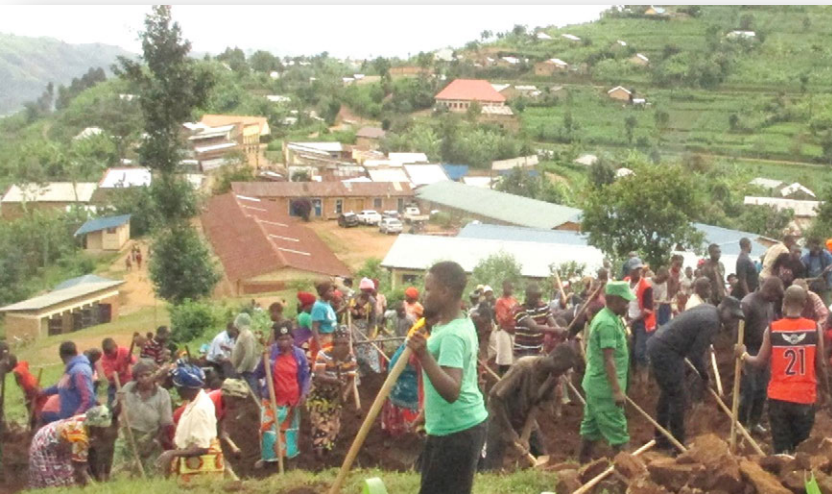
Preparación del terreno donde se construirán las 4 aulas y los 2 talleres. Información via F. André Bilodeau
